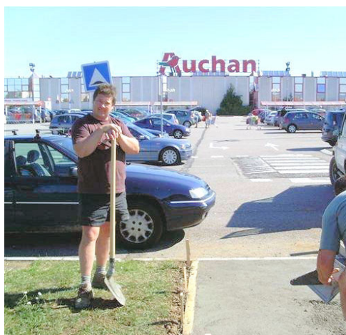
Travaux d'installation du distributeur
